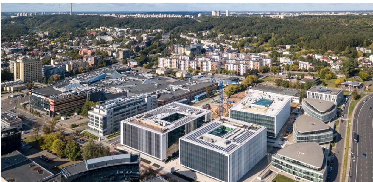
S7-området i Vilnius. S7 (i förgrunden), som förvärvades av Eastnine 2019, har solpaneler installerade på de platta taken.
